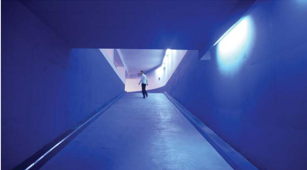
Le parc de stationnement les Terrasses, situé au Sud de la Zac Seine-Arche, est un long tube de béton enterré sous l'autoroute A14. Deux premiers niveaux communiquent avec un 3<sup>ème</sup> niveau situé sous l'autoroute dans les limites de son emprise, sur une longueur de 340 mètres. L'ensemble du troisième niveau suit la pente douce à 1.5 % de l'autoroute.
