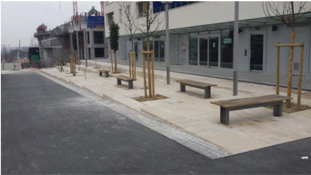
La fosse d'arbres n°4 en cours d'avancement : asphalte de la voie pompiers, caniveau en pavés granit, dalles en béton crème, arbres et arbustes, bancs avec éclairage intégré, mâts lumineux, caniveau linéaire en fonte, pavés granit en pied d'immeuble. A l'angle du bâtiment commence un escalier de 12 marches de granit.
