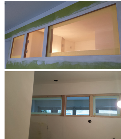
Imposte vitrée de la salle d'eau, sur ses deux faces
