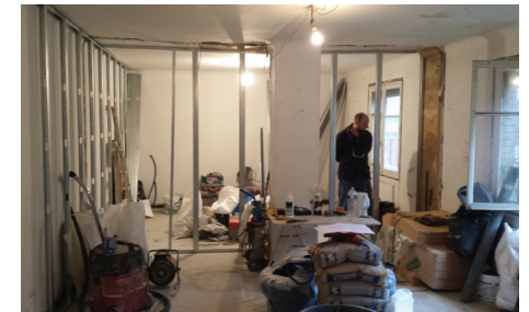
Appartement mis à nu Montage cloison chambre et isolation
