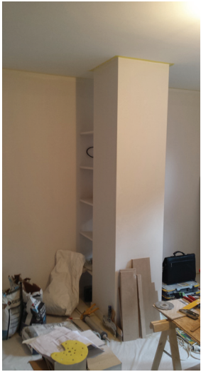
Dans le salon, habillage du conduit de cheminée qu'il a fallu maintenir, équipé d'étagères
