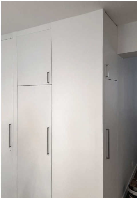
Photographies après livraison : rangements sur mesure, reprise de rangements existants et cuisine
