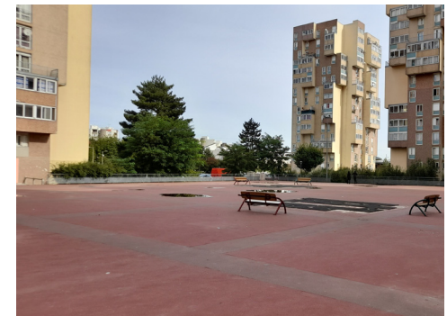
Dalle du parking en surface
