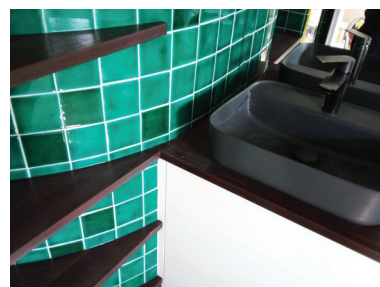
Détail du raccord entre le carrelage arrondi et les étagères en hêtre rétif
