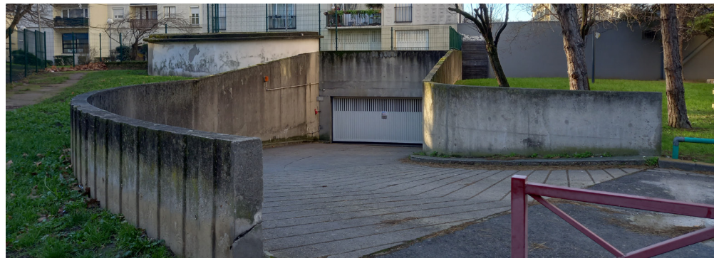
Une des rampes existantes vers les stationnements enterrés [cliché VOX/OGI]
