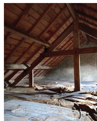
Vue des combles existants
