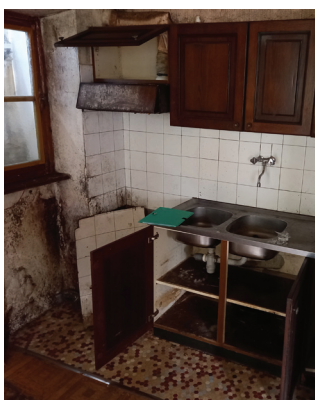
Vue de la cuisine existante
