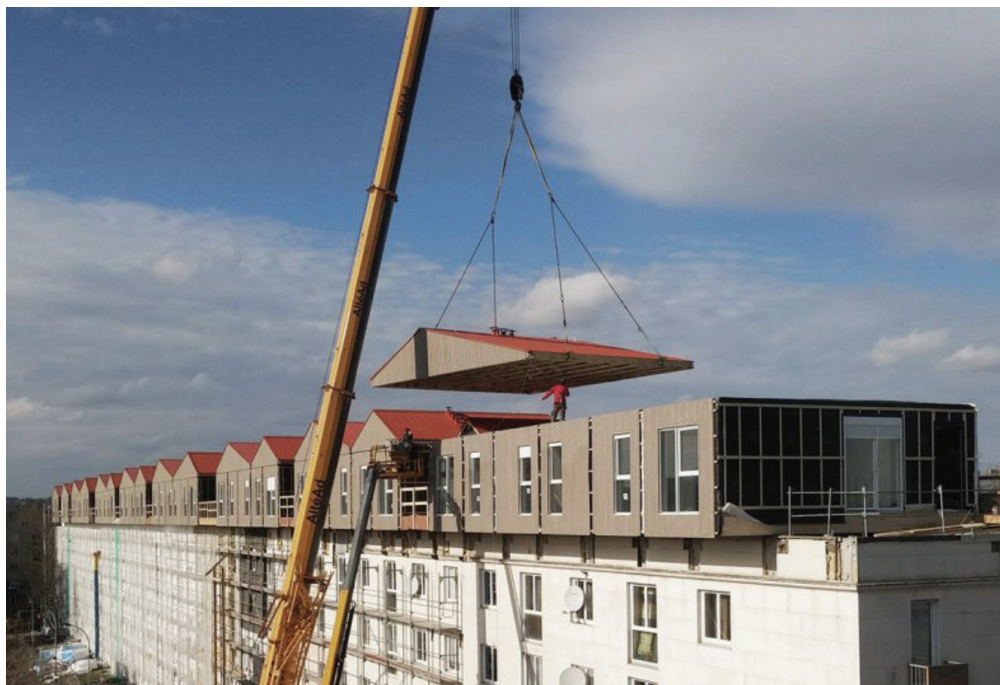
Surélévation d'une barre des années 70 à Poissy, pour Vilogia
