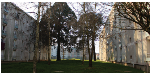
Deux vues du cœur d'îlot (cliché VOX/OGI)
