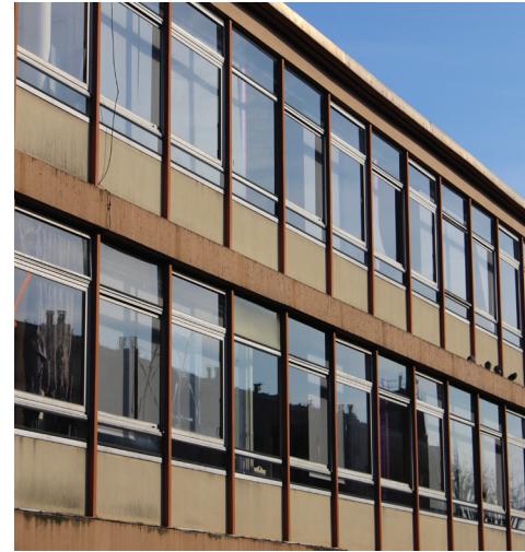
Le groupe scolaire Joliot-Curie depuis l'ouest (cliché VOX/OGI)
