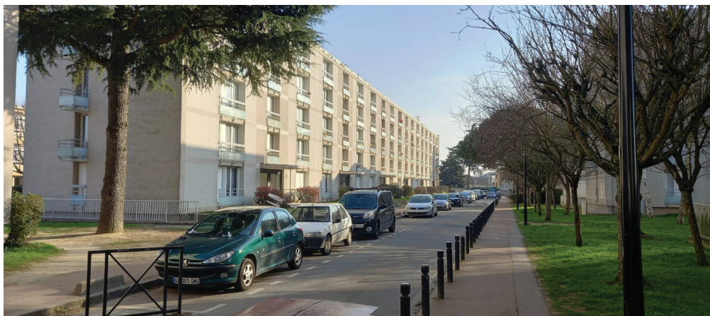
Rue Joliot-Curie, rue du Clos des Beauges et allée des Yvelines (cliché VOX/OGI)
