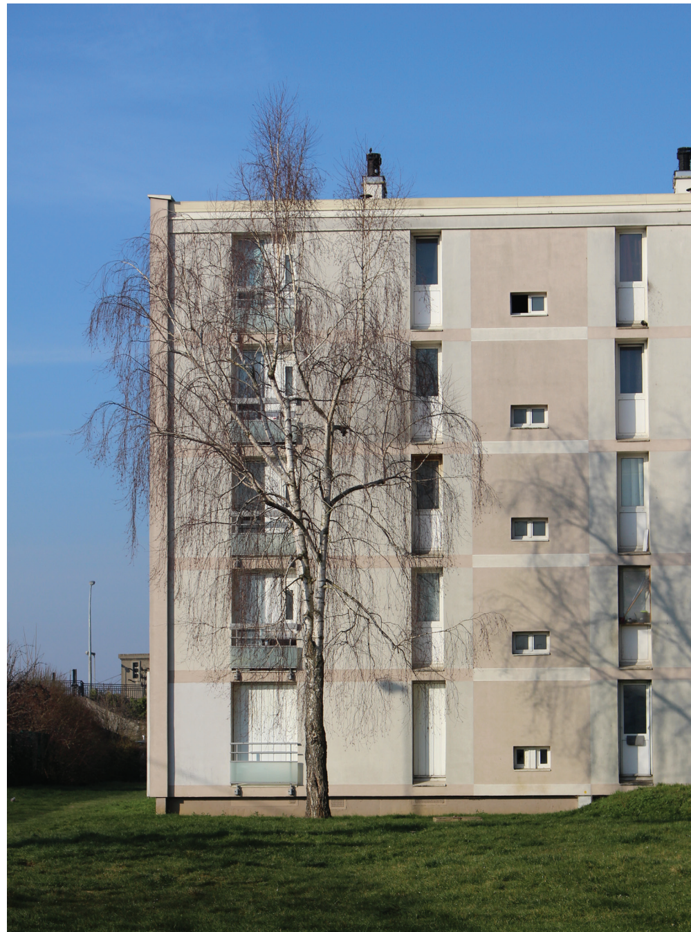
Barre de logements à R+4, quartier des Yvelines (cliché VOX/OGI)
