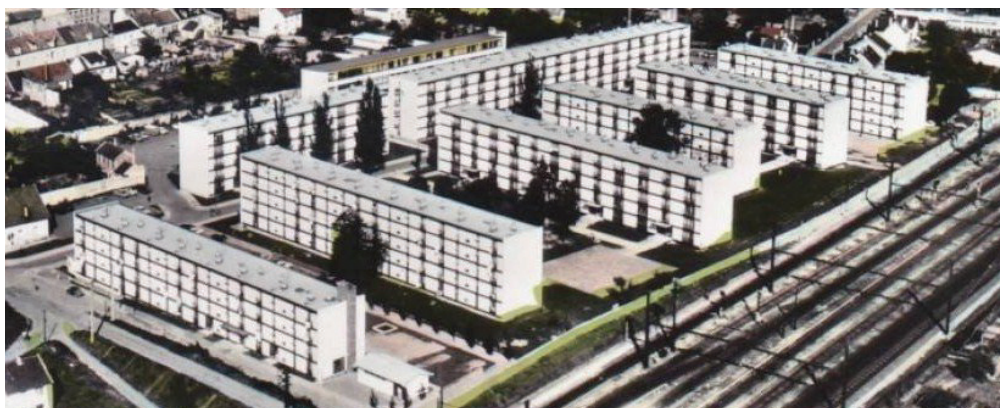
La résidence des Yvelines dans les années 70, avec un cheminement le long des voies ferrées
