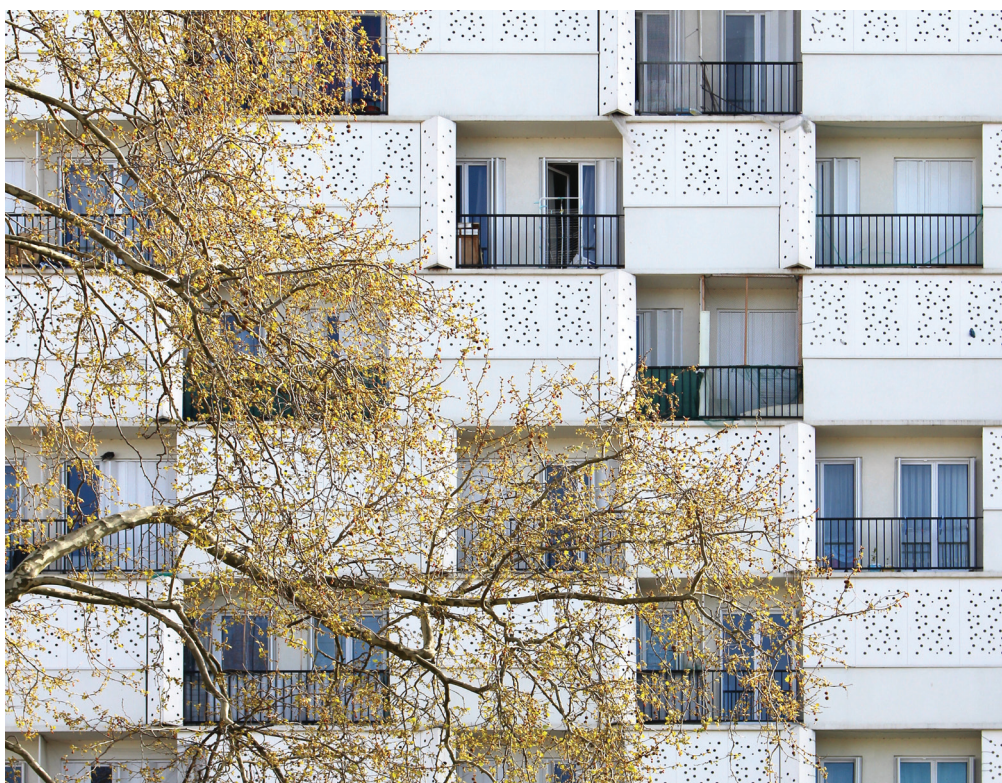
Tour des Résédas, quartier du Parc (cliché VOX)
