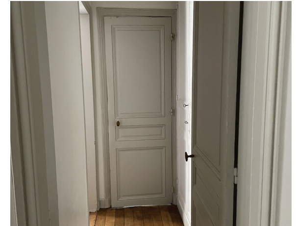
Couloir de l'appartement ouest (future connexion entre les deux lots)
