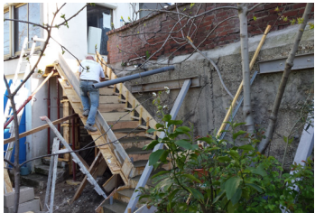
Coffrage de l'escalier avant coulage
