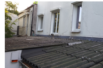
L'ancienne toiture en fibrociment
