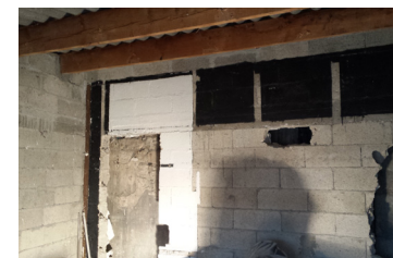
Dépose du contre-mur de la future cuisine
