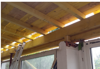
Charpente intérieure sur poteaux anciens renforcés
