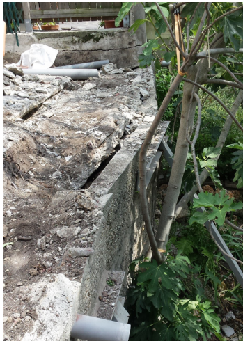
La terrasse très fragilisée par un mur de soutènement de structure trop légère
