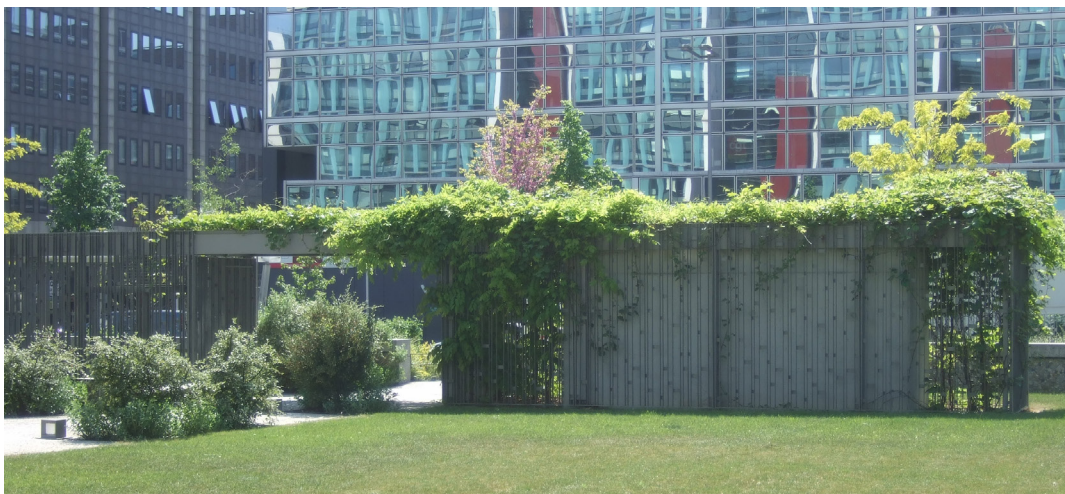
Édicule intégrant une VH de 4m 2 , ainsi qu'une sortie de secours de l'A14
